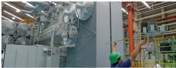
Distancia correcta entre radiadores y contenedores ambiente
