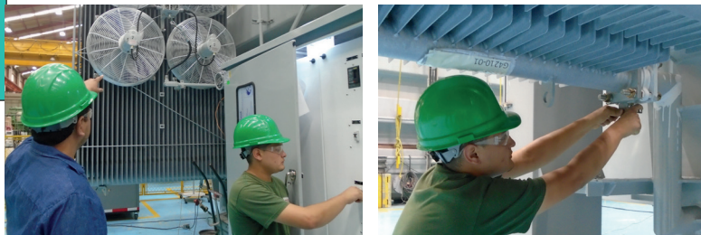
Encendido y aseguramiento del sentido de giro de los ventiladores
